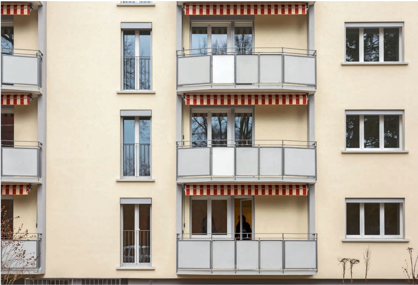
Die renovierte Südfassade mit den neuen, raumhohen Fenstern der vier zusätzlichen Zimmer.
