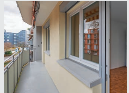
Balkon mit erneuertem Bodenbelag.
