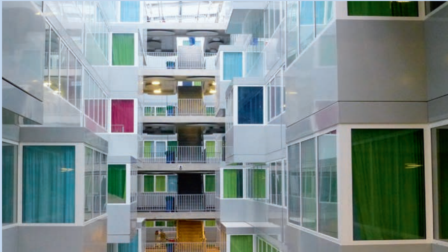
Innenhof des neuen «Bâtiment D» der Cité Universitaire de Genève.
